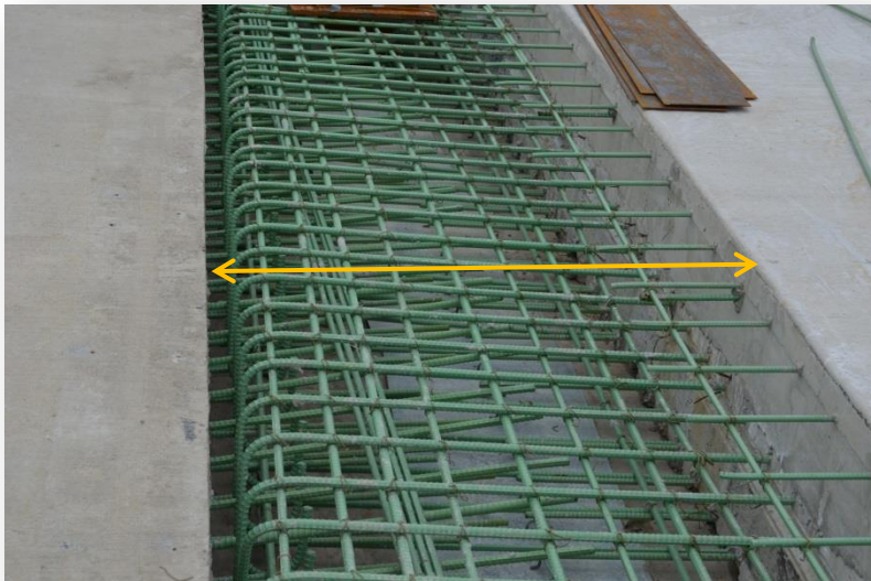
Bridge Deck Closure Pour
